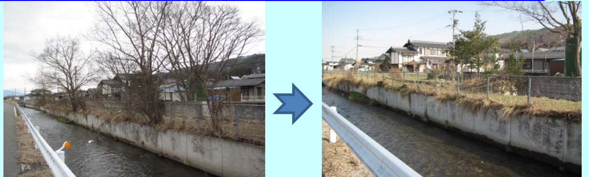
内川河川際の立木伐採作業
