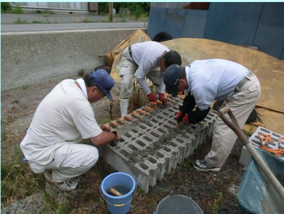
用水路、水止め用加工ブロック作成の様子
