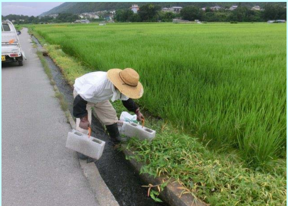
水止め用ブロック設置（各田水口）
