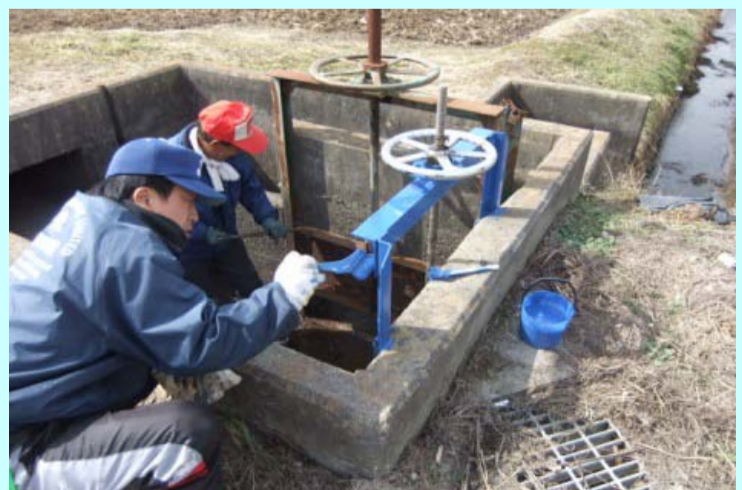
ゲート類塗装 付帯施設の適正管理
