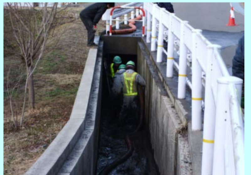
暗渠用水路の泥上げ清掃
