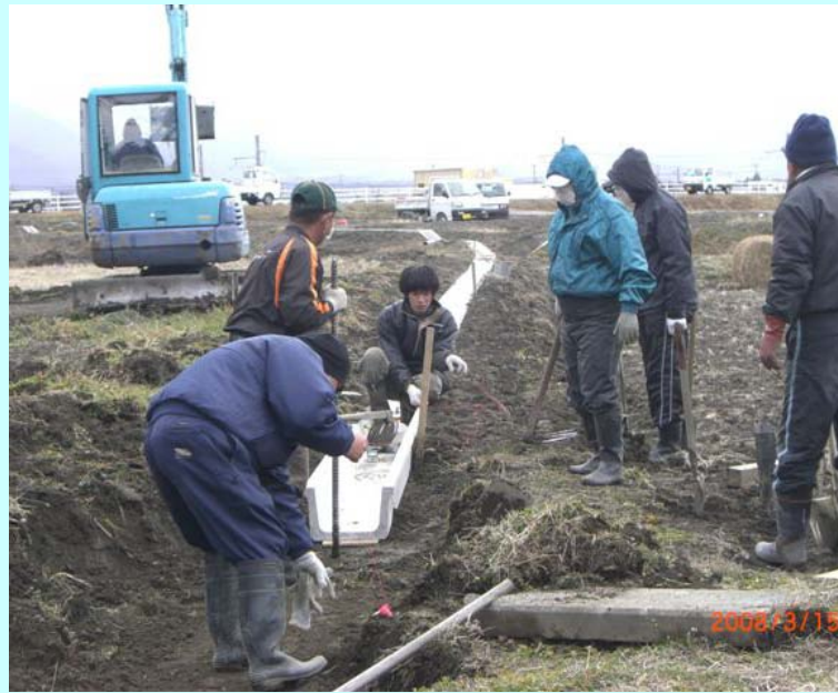
U字溝敷設工事
