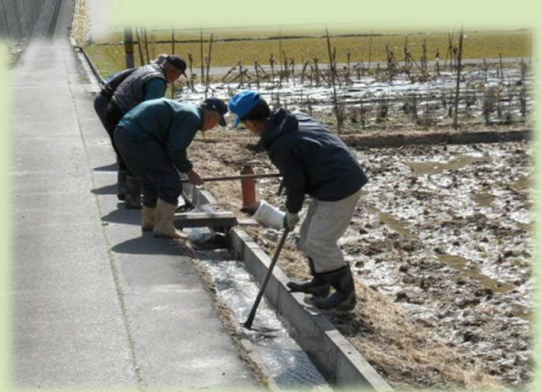
水路の泥上げ
