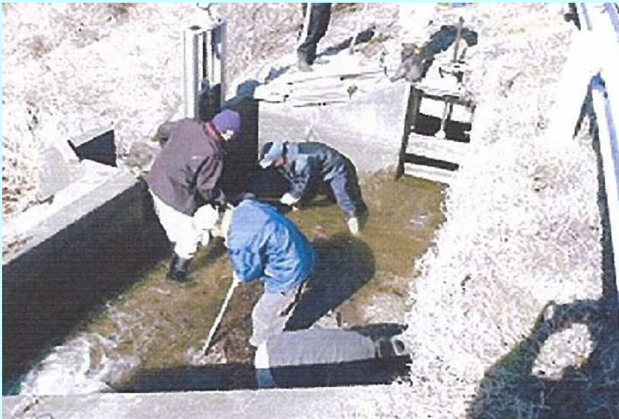
水路の泥上げ
