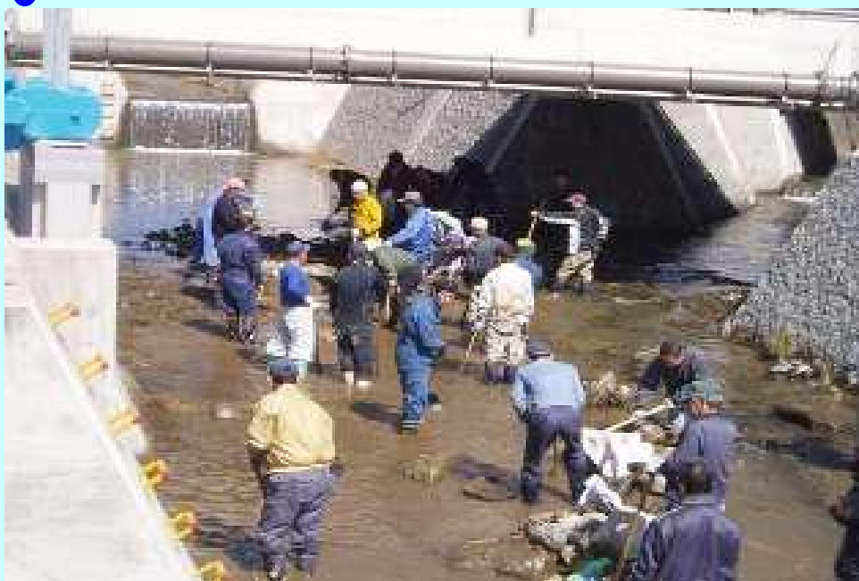
用水取り入れ口の堆積土砂を除去
