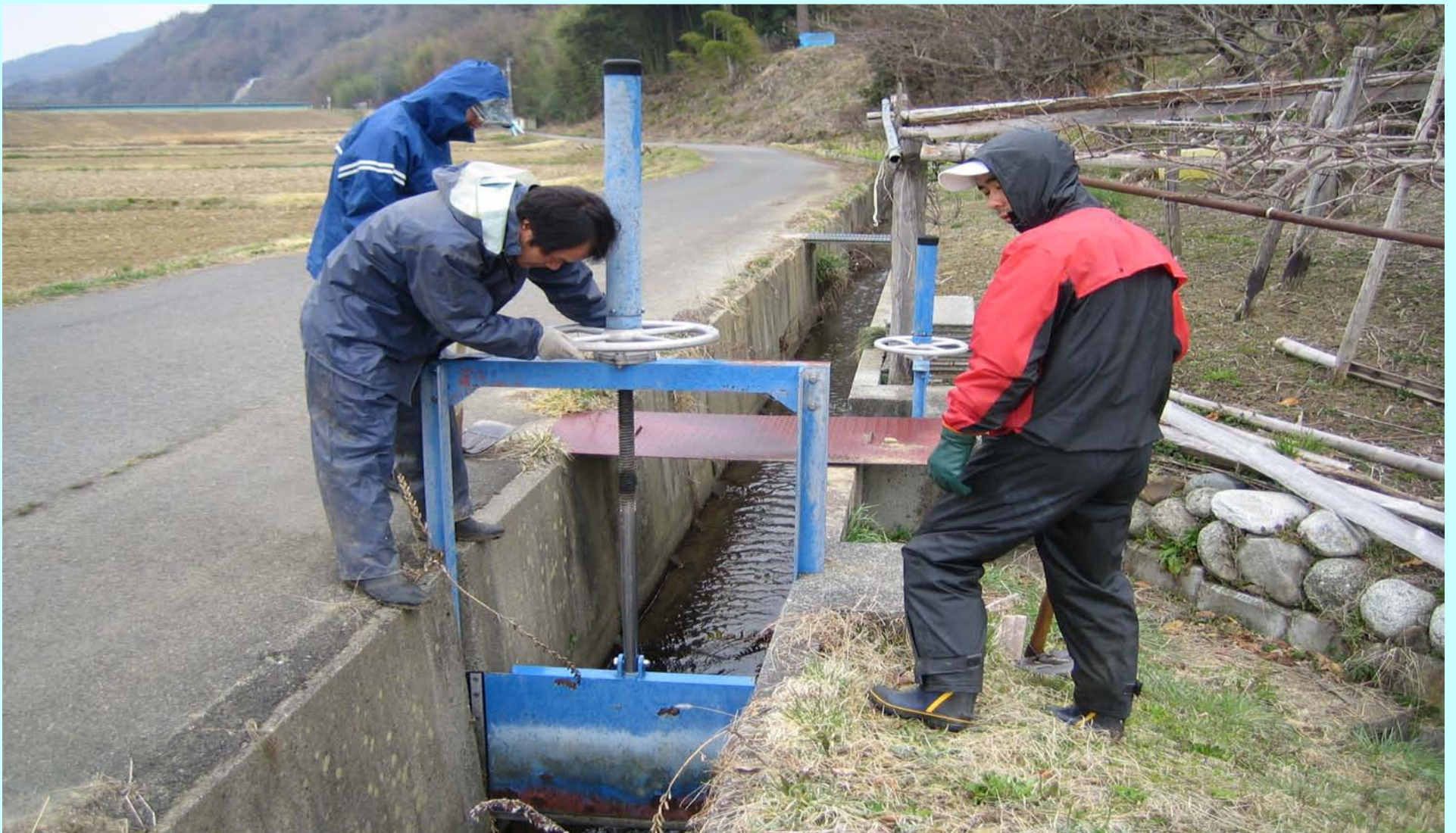
開水路の施設点検・配水操作・機能診断の実施
