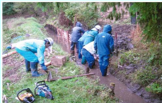
素掘水路の破損補修
