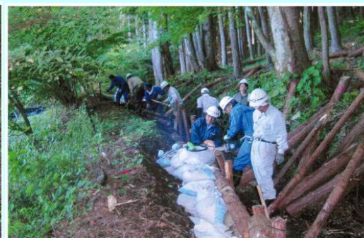
素掘水路の破損補修
