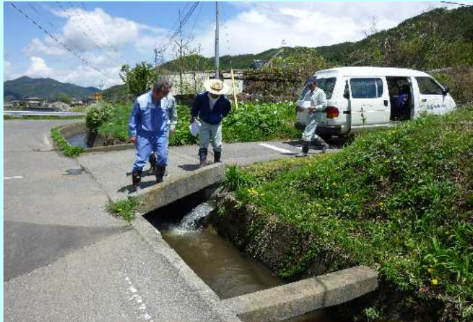
主要水路（大堰）の点検
