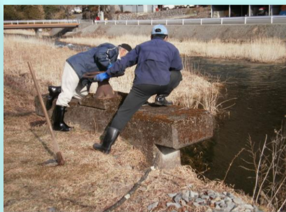
水門の点検作業です
