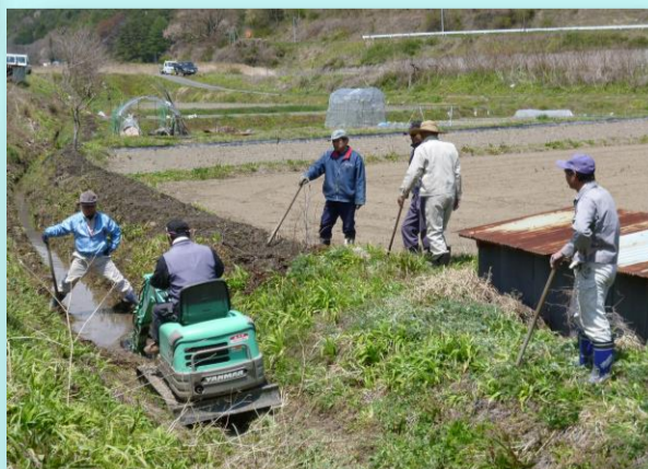
埋没した排水路の泥上げ作業
