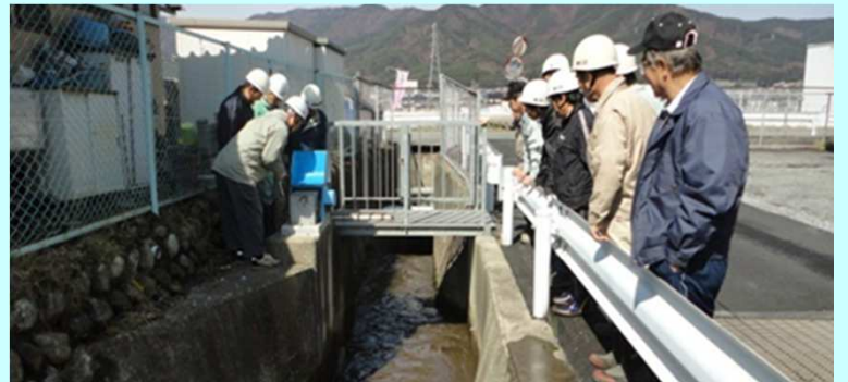
施設の機能診断
