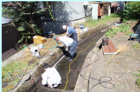
農用水路の漏水防止工事
