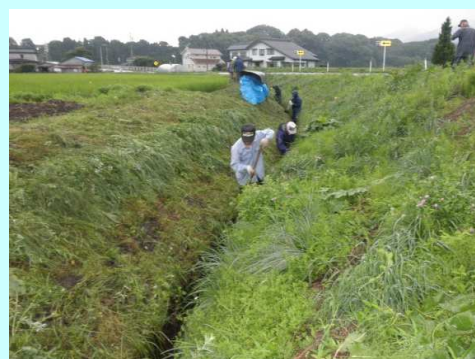
水路の泥上げ
