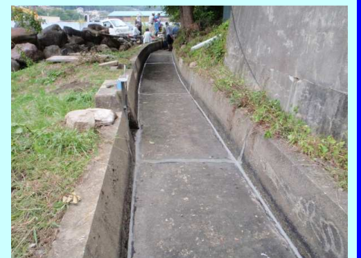
農用水路の漏水防止工事
