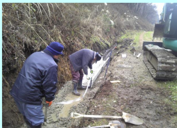
役員による水路改修工事
