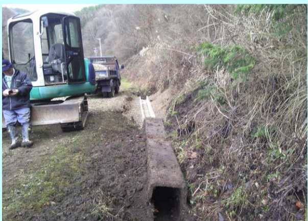
古いBFを蓋にして第一工区完了
