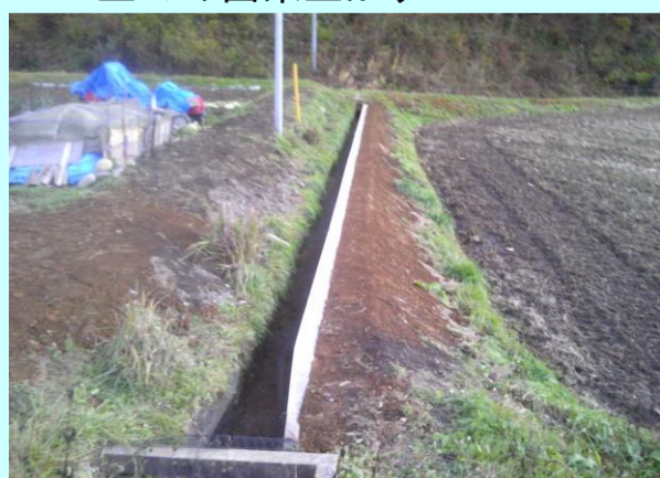
念願のBFかさ上げ工事 業者発注工事
