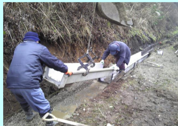
重機を使つてのBF敷設替え
