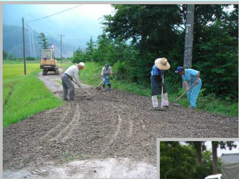
農道の保全 (碎石を補充し敷き均し)
