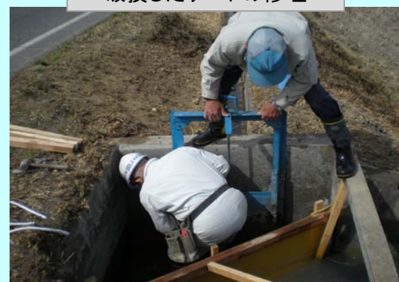
破損したゲートの修理
