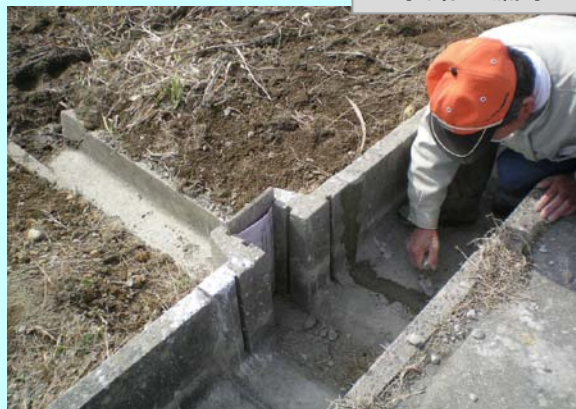
水路の漏水か所の修理
