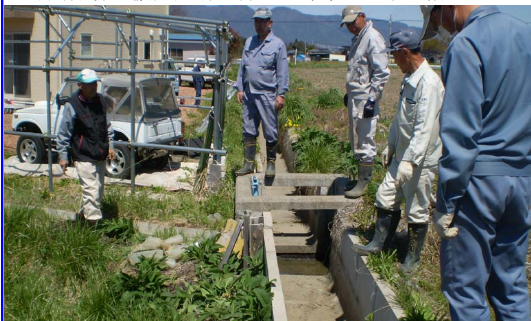
下手良支部 : 水路の適正管理を実施するため、支部関係者が機能診断を行い、毎年の通水に備える。
