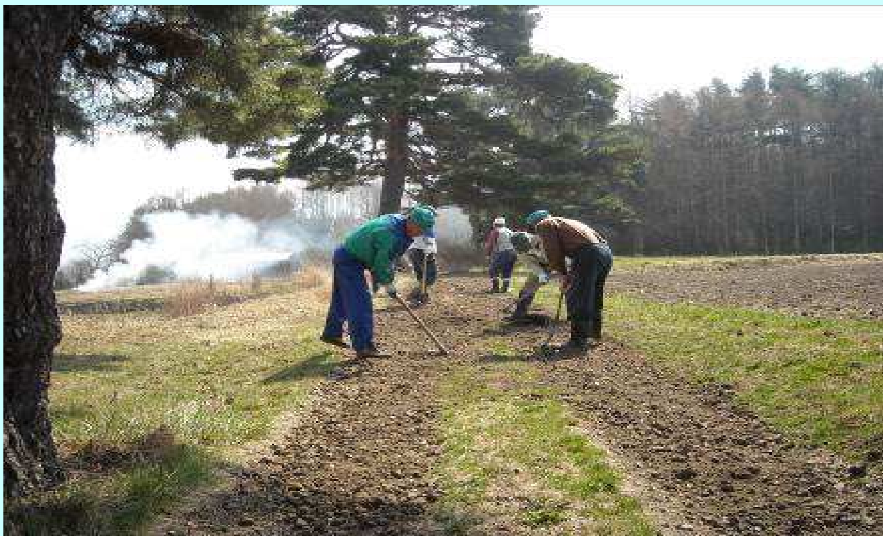
— 農道の補修(碎石敷き)作業 — 役員が見回りをし、作業箇所を決定し実施します。
