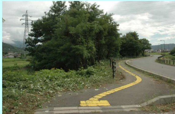
農道と通学路の保全のため、ふるさと農道沿いに繁茂したアカシヤの枝払いを
