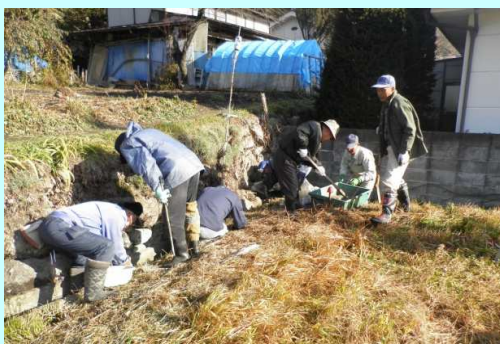
水路の目地詰め
