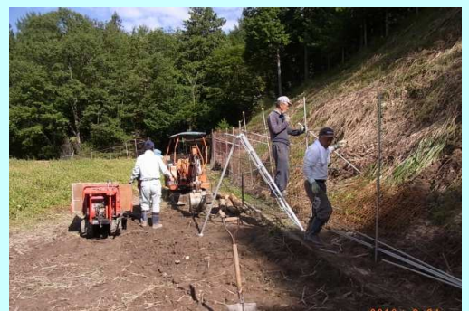
鳥獣防護柵の補修
