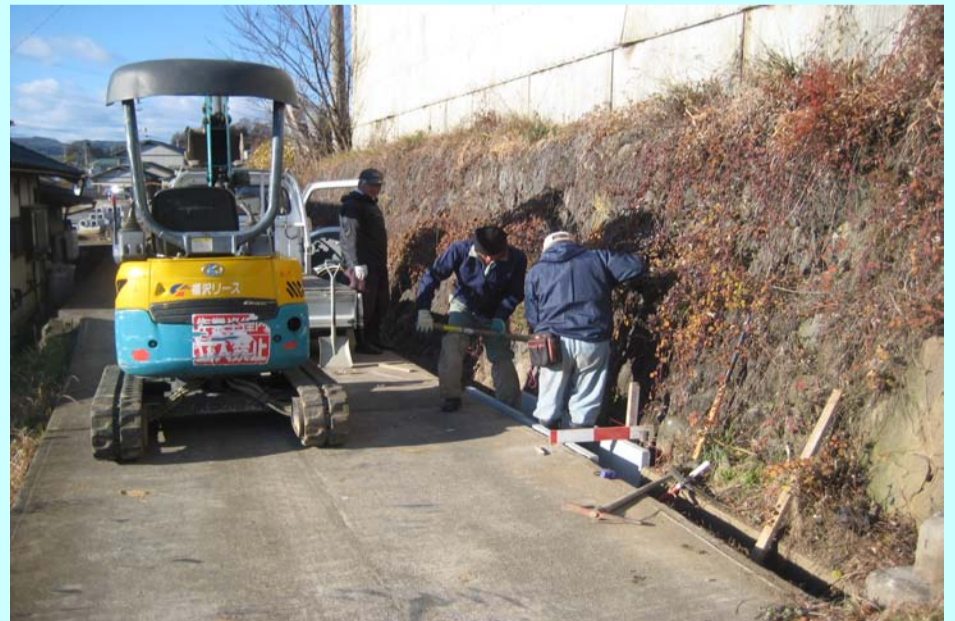
農道の側溝補修作業
