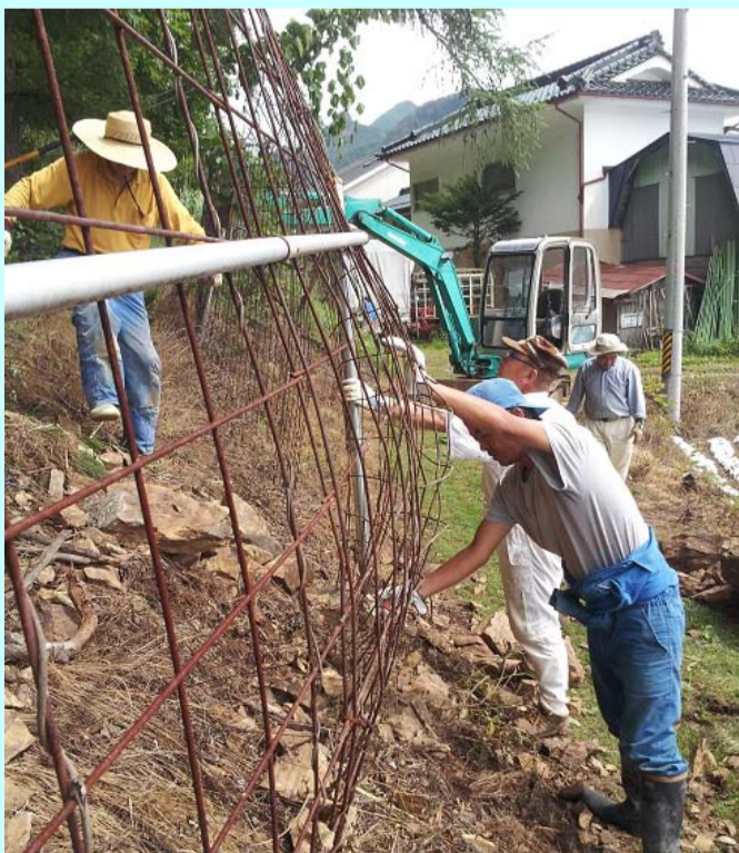
ニホンジカによる被害を防ぐために設置した侵入防護柵の点検や修繕を行っています。
