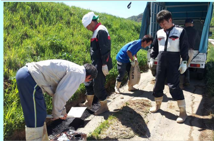
農道の穴などを埋め、整備しています。
