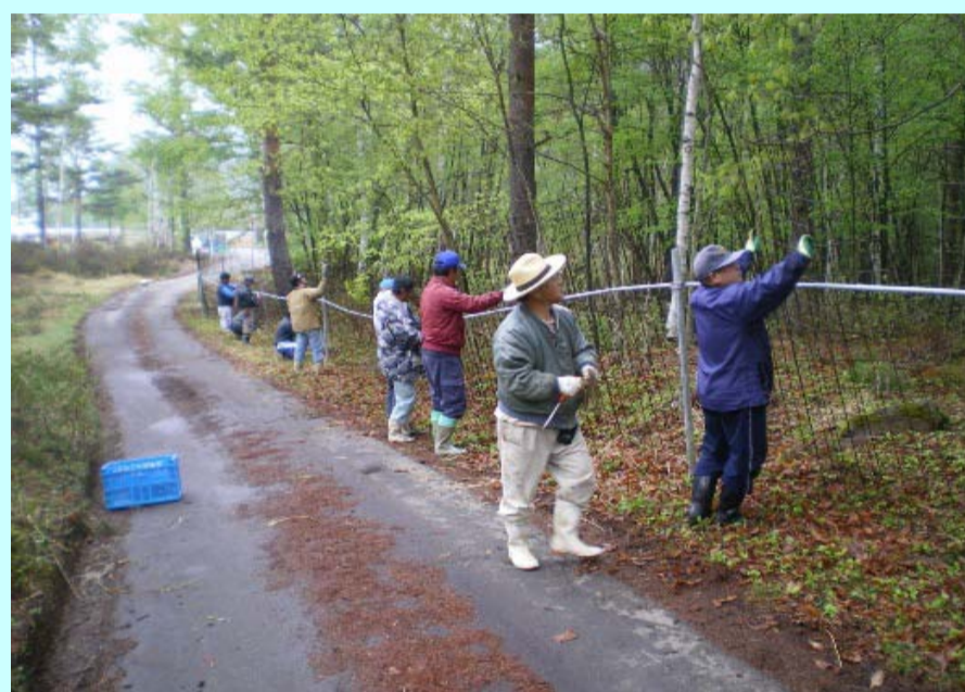
防護柵の修繕
