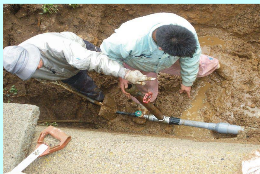
パイプラインの修繕
