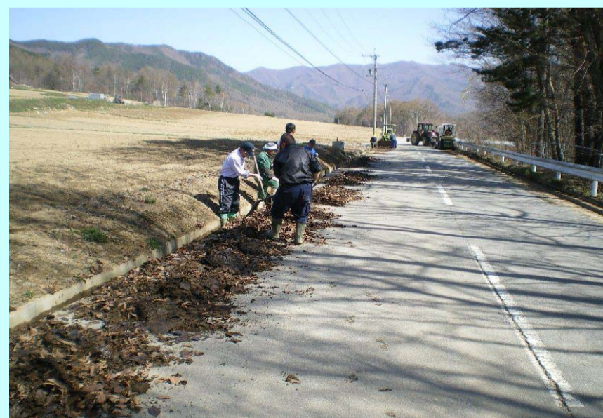
農道補修、水路の泥上げ
