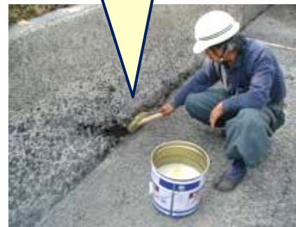
プライマー塗布
