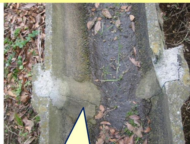
セメントモルタルによる補修後
