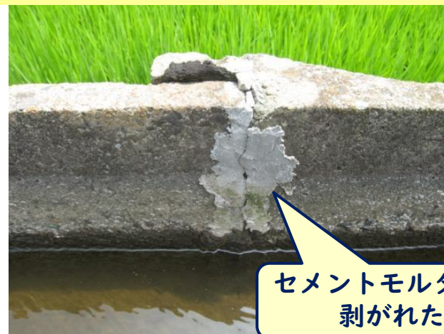
セメントモルタルによる補修後
