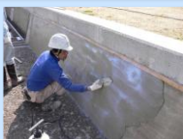
水路壁の表面被覆
