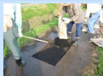
農道舗装の打換え
