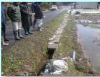
施設の機能診断
