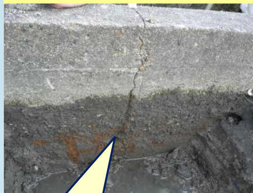
縦方向のひび割れ
