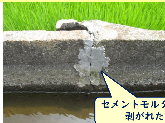
セメントモルタルによる補修後
