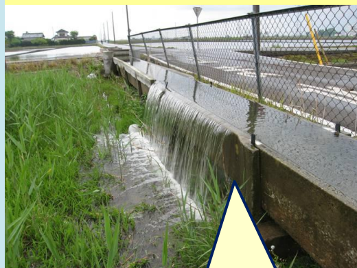
沈下による溢水
