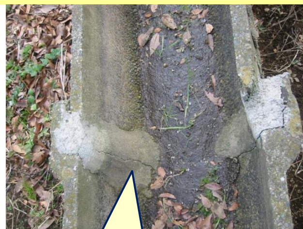
セメントモルタルによる補修後
