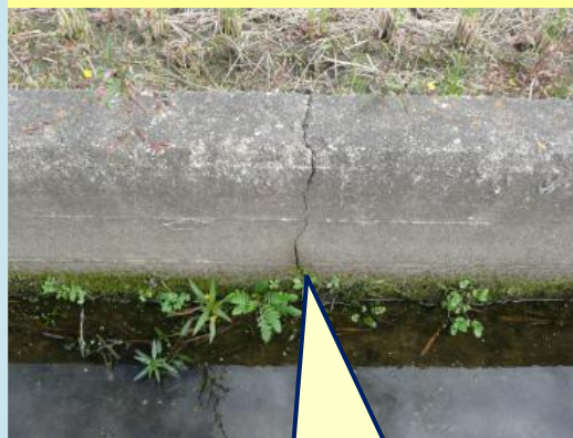
縦方向のひび割れ
