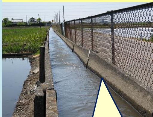
沈下による変形
