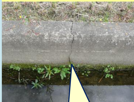
縦方向のひび割れ
