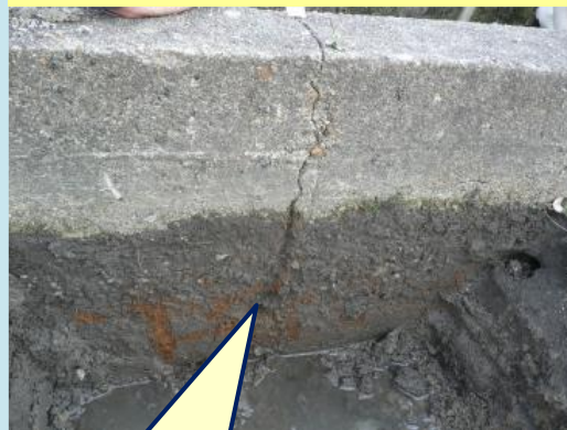
縦方向のひび割れ
