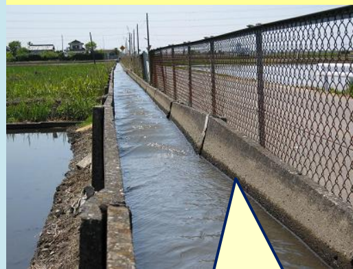
沈下による変形
