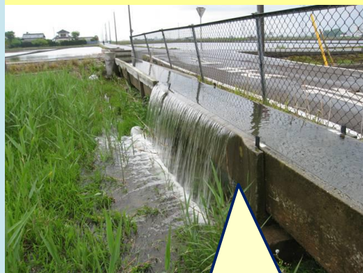
沈下による溢水
