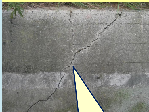
斜め方向のひび割れ
