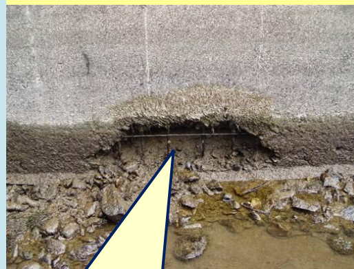
鉄筋が露出した穴あき
