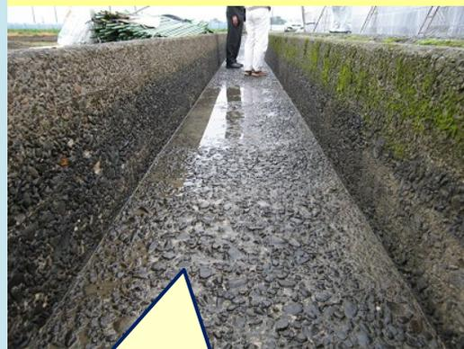
摩耗により骨材が露出・
