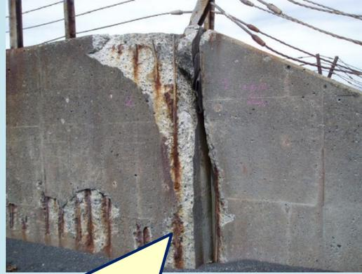
コンクリートのアルカリ性が低下し、鉄筋が腐食
