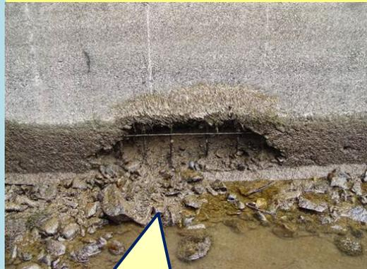
穴が深く(3cm以上)で鉄筋が露出している
