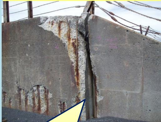
コンクリートのアルカリ性が低下し、鉄筋が腐食
