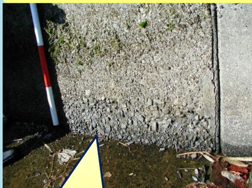
流水などにより骨材の一部はく落している
