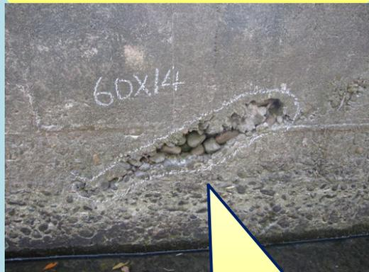
穴が浅く(3cm未満)で鉄筋が露出していない
