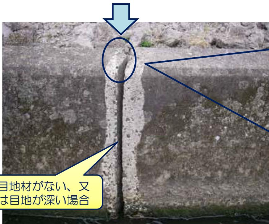
バックアップ材は、シーリング材の充填深さを調整する役割があります。シーリング材の充填深さの目安としては、目地幅10~20mmであれば、充填深さ10mm程度となります。
