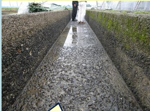
摩耗により骨材が露出・はく落し、凹凸が著しい
