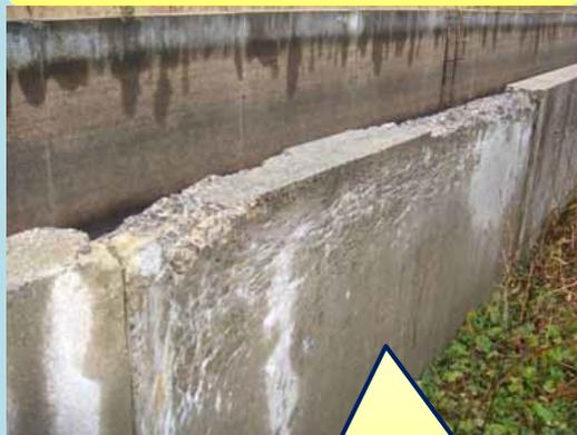
欠損や、水平方向のひび割れが層状に発生
