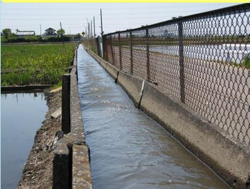
地盤が沈下し、水路が傾くなどの変形が発生
