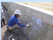
水路壁の表面被覆
