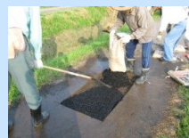
農道舗装の打換え
