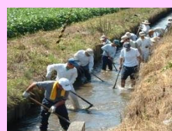
水路の泥上げ
