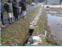
施設の機能診断
