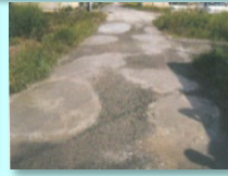
農道の窪みの補修
