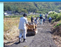
未舗装農道を舗装
