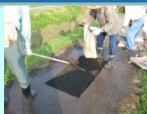
農道舗装の打換え
