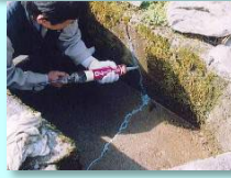
水路のひび割れ補修
