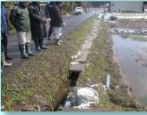
施設の機能診断
