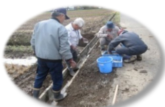
自主施工での水路補修
