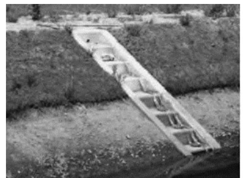
斜樋と取水栓（コンクリート製品）
