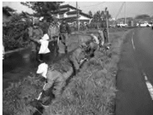
側溝の泥上げ
