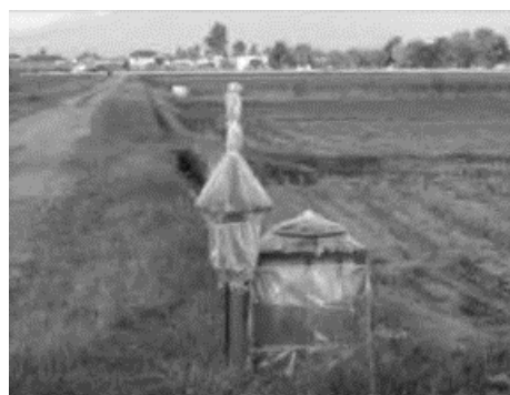
ゲートの被覆状況
