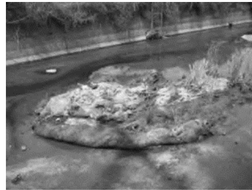
土砂の堆積状況
