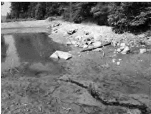
ため池に流入した土砂
