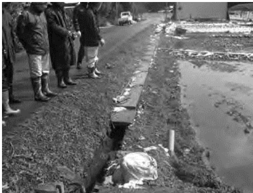
開水路の点検状況
