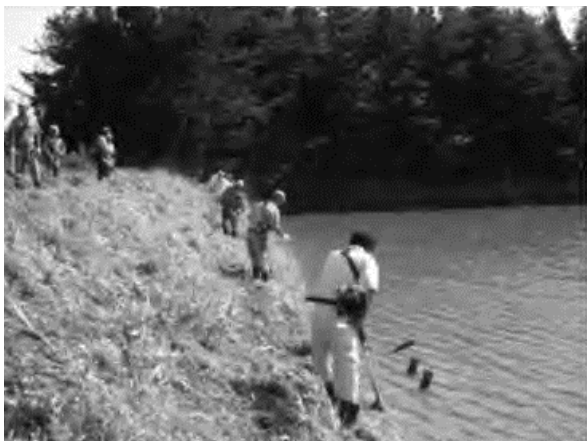
ため池堤体の草刈り
