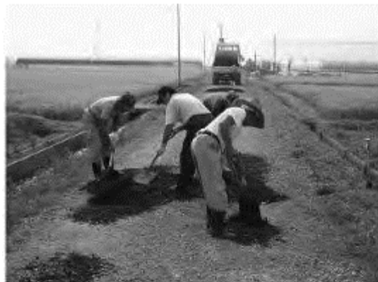
共同作業による砂利の敷き均し
