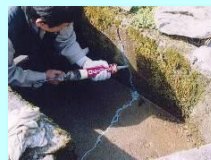
水路のひび割れ補修
