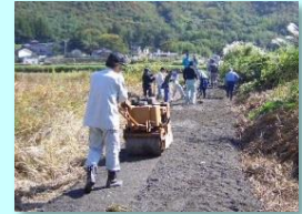
未舗装農道を舗装
