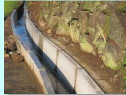
既設フリュームの更新
