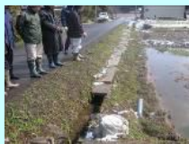
施設の機能診断
