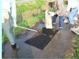
農道舗装の打換え
