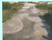
農道の窪みの補修
