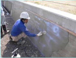
老朽化した水路壁のコーティング
