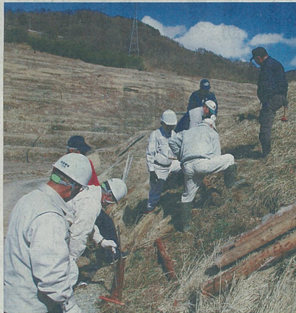
3月16日に上田市で開かれた法面に小段を設置する技術研修会
