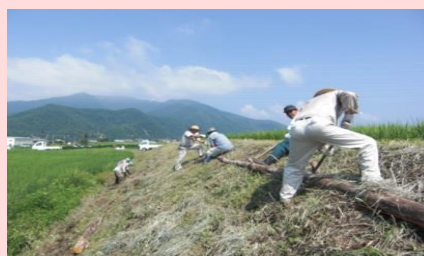
法面への小段の設置作業風景
