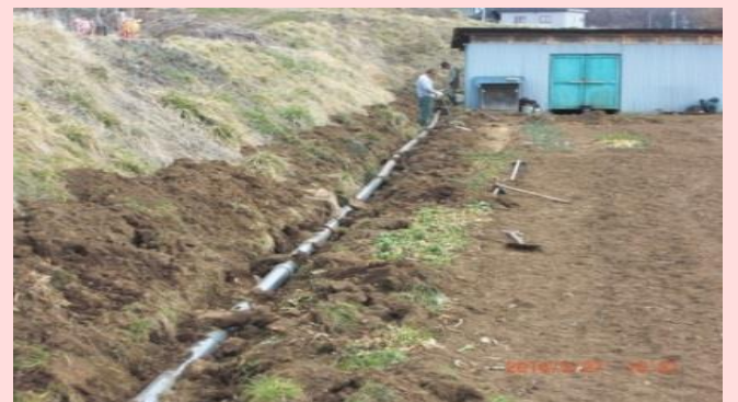
資源向上(長寿命化)としての暗渠埋設工事
