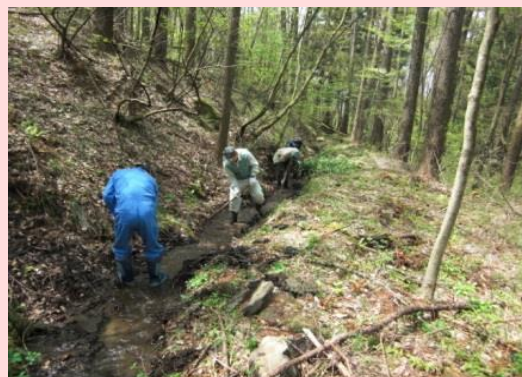
山間部の水路整備作業
