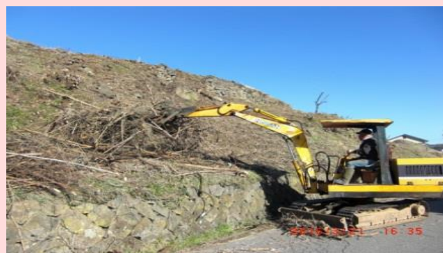
大きな法面と水路周辺の整備作業
