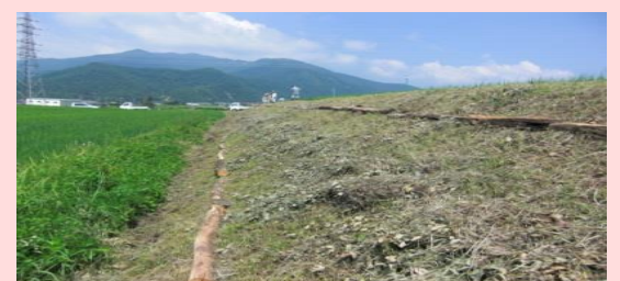
小段設置後の法面
