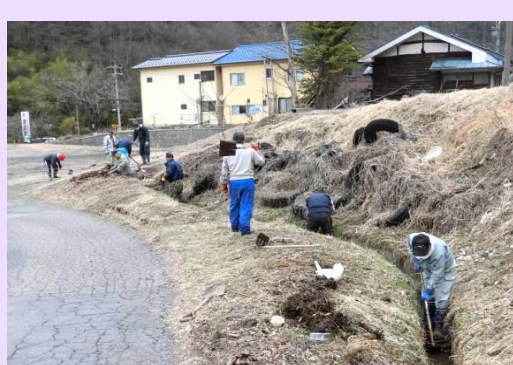
水路の土砂上げ
