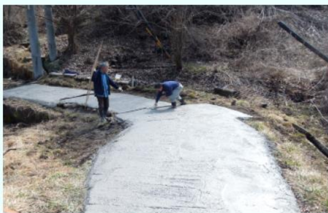
法性寺農道のコンクリート舗装作業
