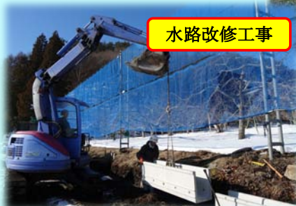
水路整備工事風景
