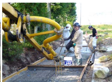
舗装改修作業
