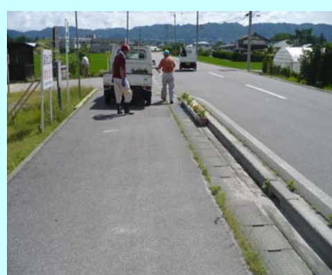
プランターの設置
