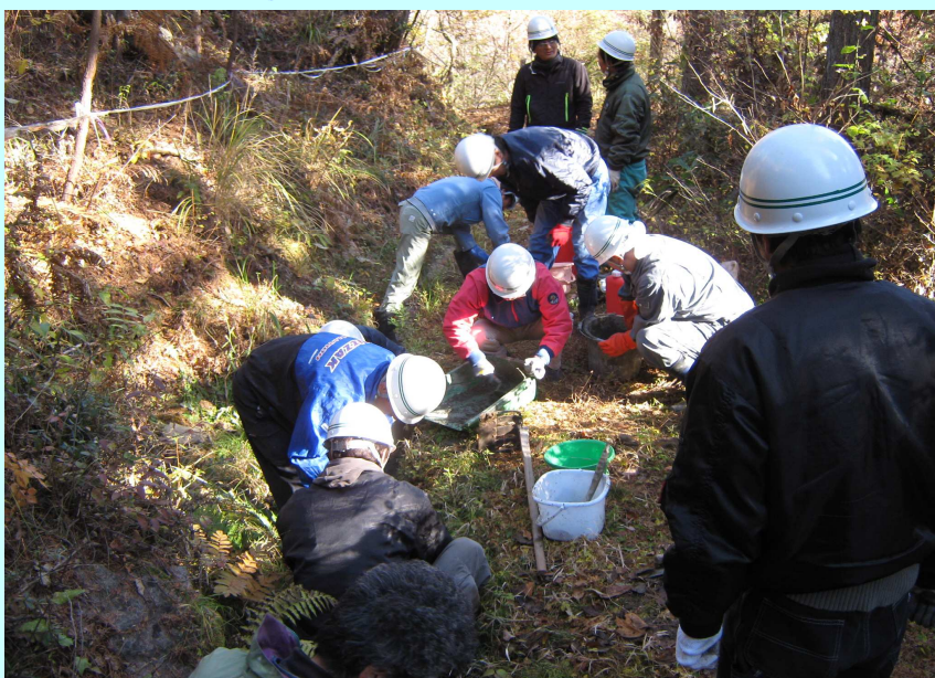
水路の泥出し、間詰め作業
