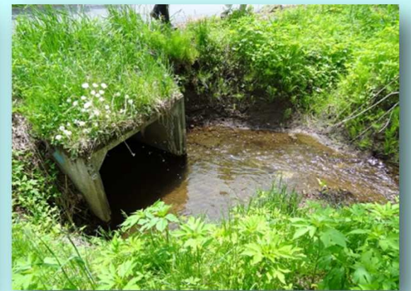
水路の現況調査・・・水路の法面が崩れ、水が対流し上流からの水を堰き止め、水害をもたらした箇所
